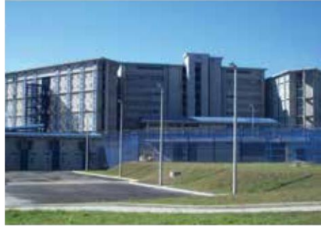
Carcel Picaleña Carpintería metálica Ibagué - Tolima
