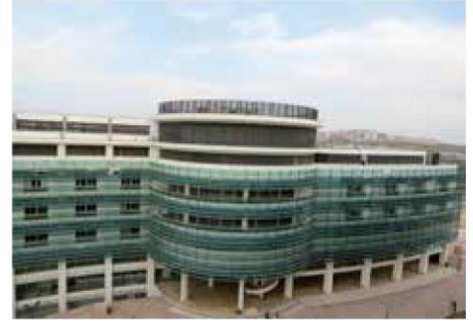
Clínica Porto Azul Estructura y carpintería metálica Barranquilla - Atlántico
