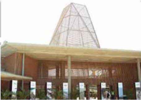
Fundación Pies Descalzos Estructura metálica Cartagena - Bolívar
