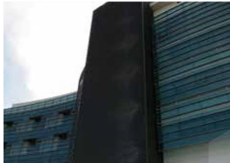
Clínica Porto Azul Cortasoles y cubiertas arquitectónicas Barranquilla - Atlántico
