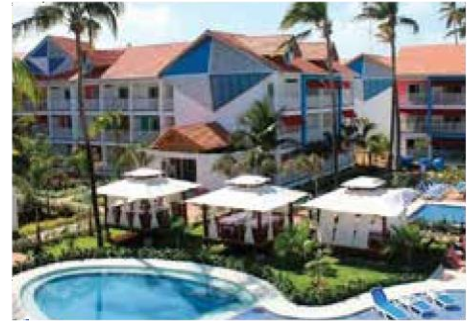
Hotel Decámeron Isleño Estructura metálica San Andrés, Providencia y Sta. Catalina
