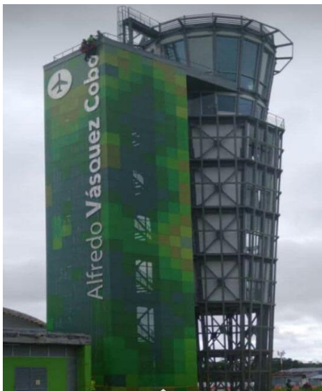
Aeropuerto Internacional Alfredo Vásquez Cobo Fachada Punzonada Arquitectónica Leticia - Amazonas
